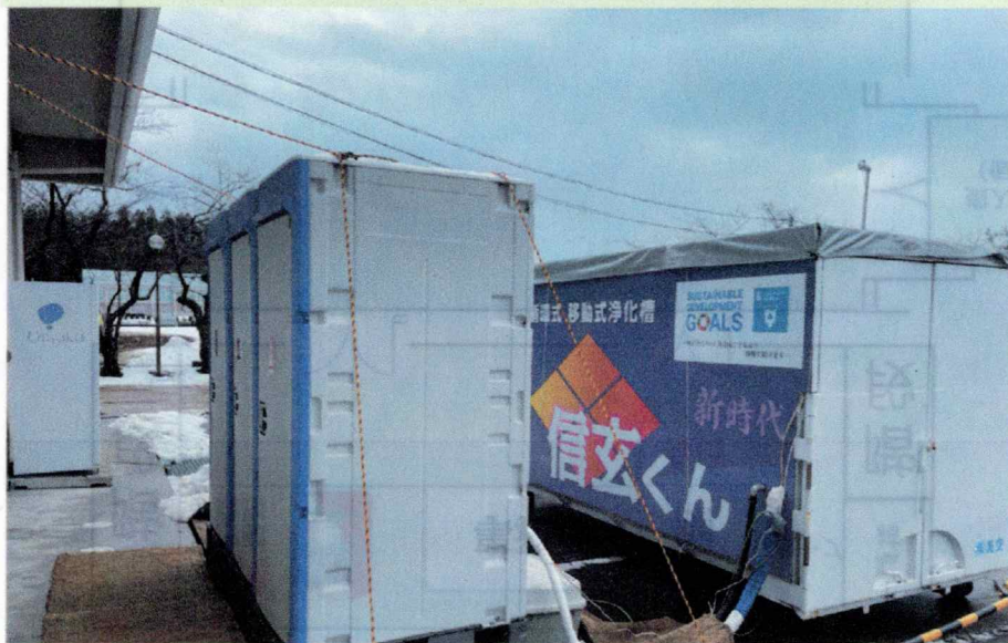
都留市到着の二日前に山梨県が設置した仮設トイレ（完全循環式・移動式浄化槽「信玄くん」が整備）
