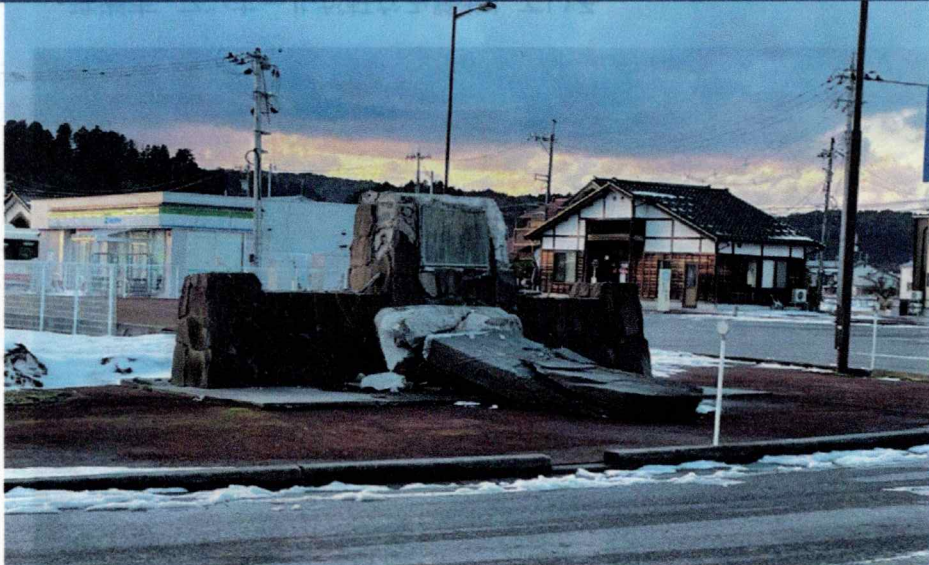
・珠洲市 道の駅「すずなり館」の破損したモニュメント
