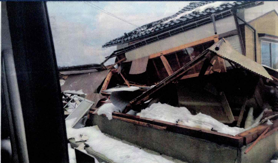
・珠洲市 大通り沿いに目立った倒壊が見られないものの一本外れると多数家屋の倒壊が見られる。
