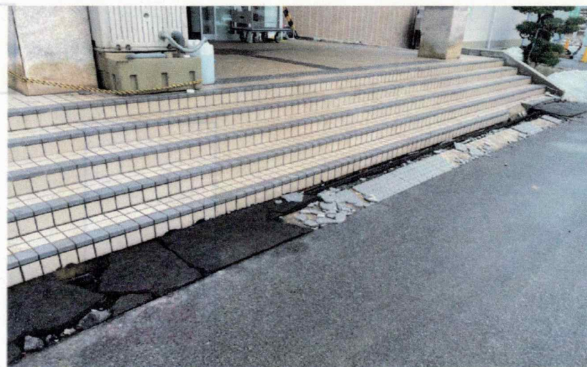
・珠洲市「珠洲市立健民体育館」入口部分
