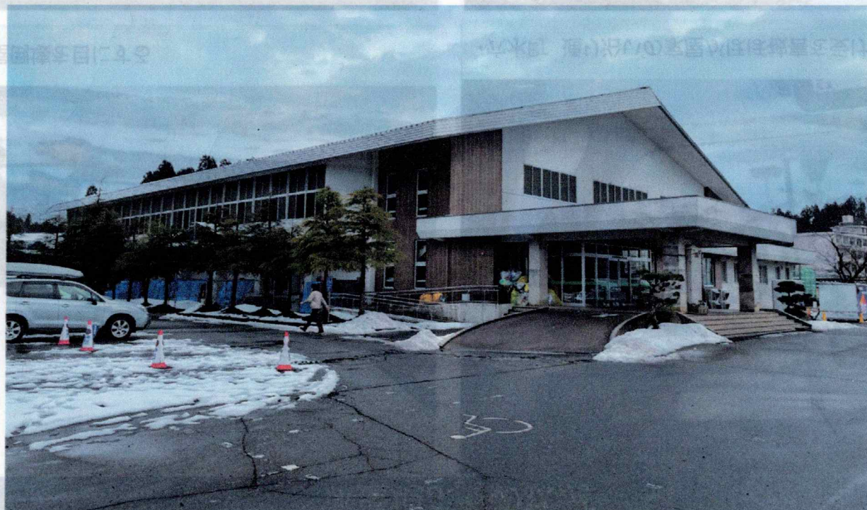
珠洲市立健民体育館
