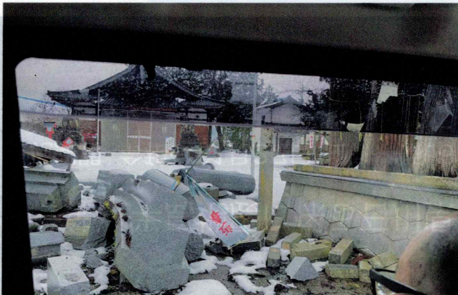
・穴水町 神社の鳥居が崩壊している（右は被害前の状態）
